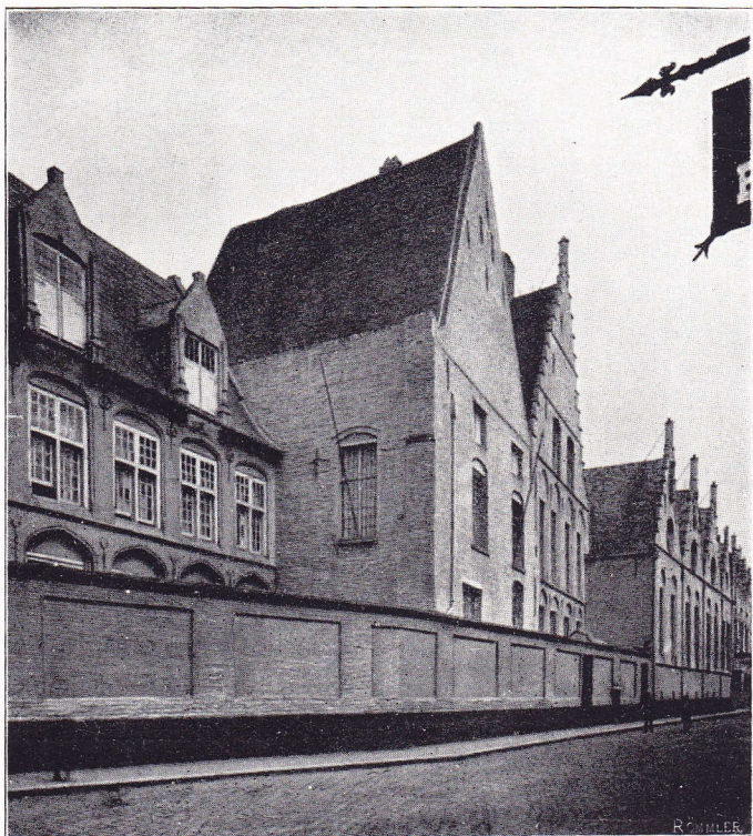
L'Hôpital, vue latérale.
