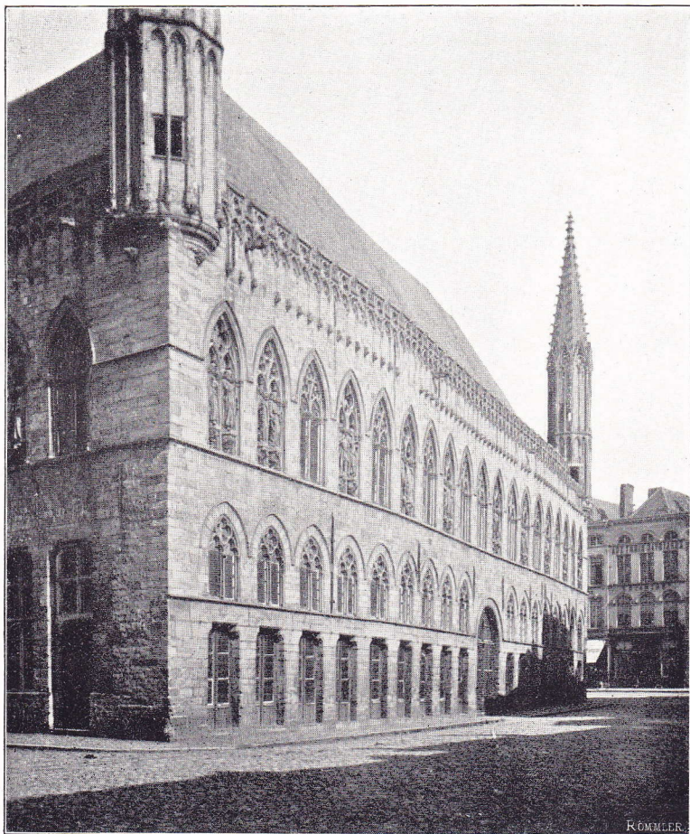
La Halle, vue latérale.
